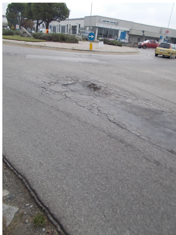
Rotatoria – particolare cedimento in Via Malpighi
